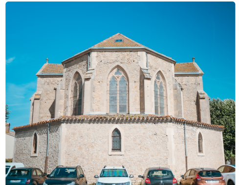
Travaux sur bâtiments communaux
