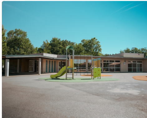
Rénovation énergétique de l'école.
